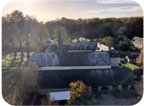
Le couvent vu de la grue du chantier
