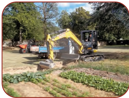
Travaux d'aménagement du jardin
