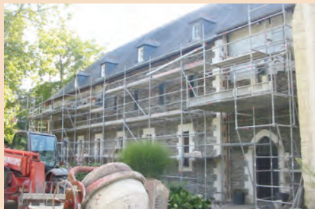
Façade Est, travaux en cours
